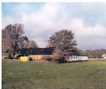
Figur 5. Liksom figur 4 är denna bild tagen från Gamla Borrebackevägen, men från sydöst. Målet är att den södra längan, i rött tegel, i framtiden ska rymma en ny samlingslokal. (Foto: Boel Persson, 2006-10-01)
